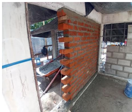
Figura 3.7-1 Típica práctica constructiva con pared de relleno de ladrillo.
