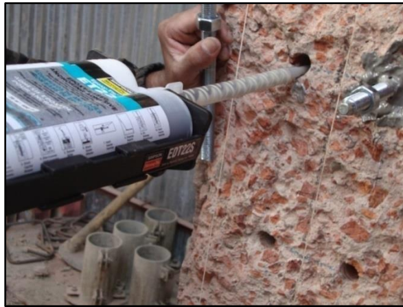
Figura 2.2-5 Aplicación del agente para unión epóxica.
