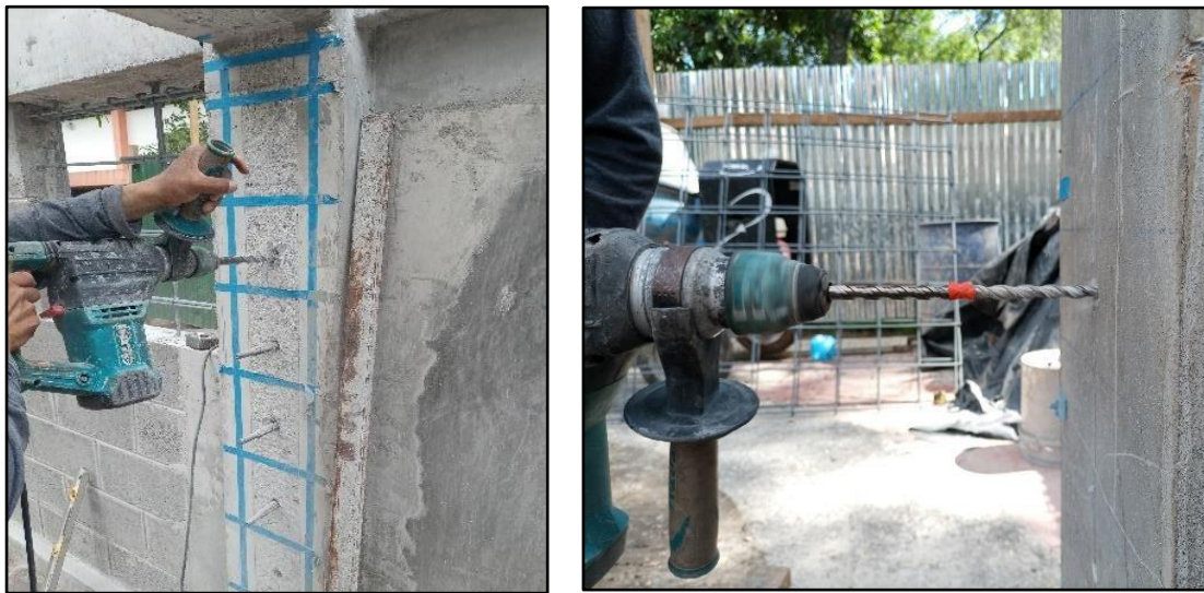
Figura 2.2-3 Perforación y marcado de profundidad de agujeros.
