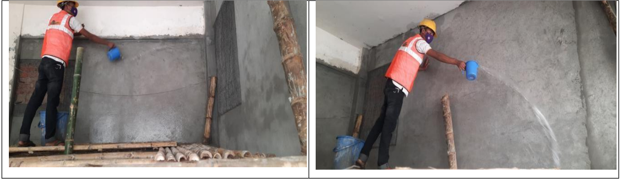
Figura 3.7-7 Trabajos de curado después de la colocación del mortero.
