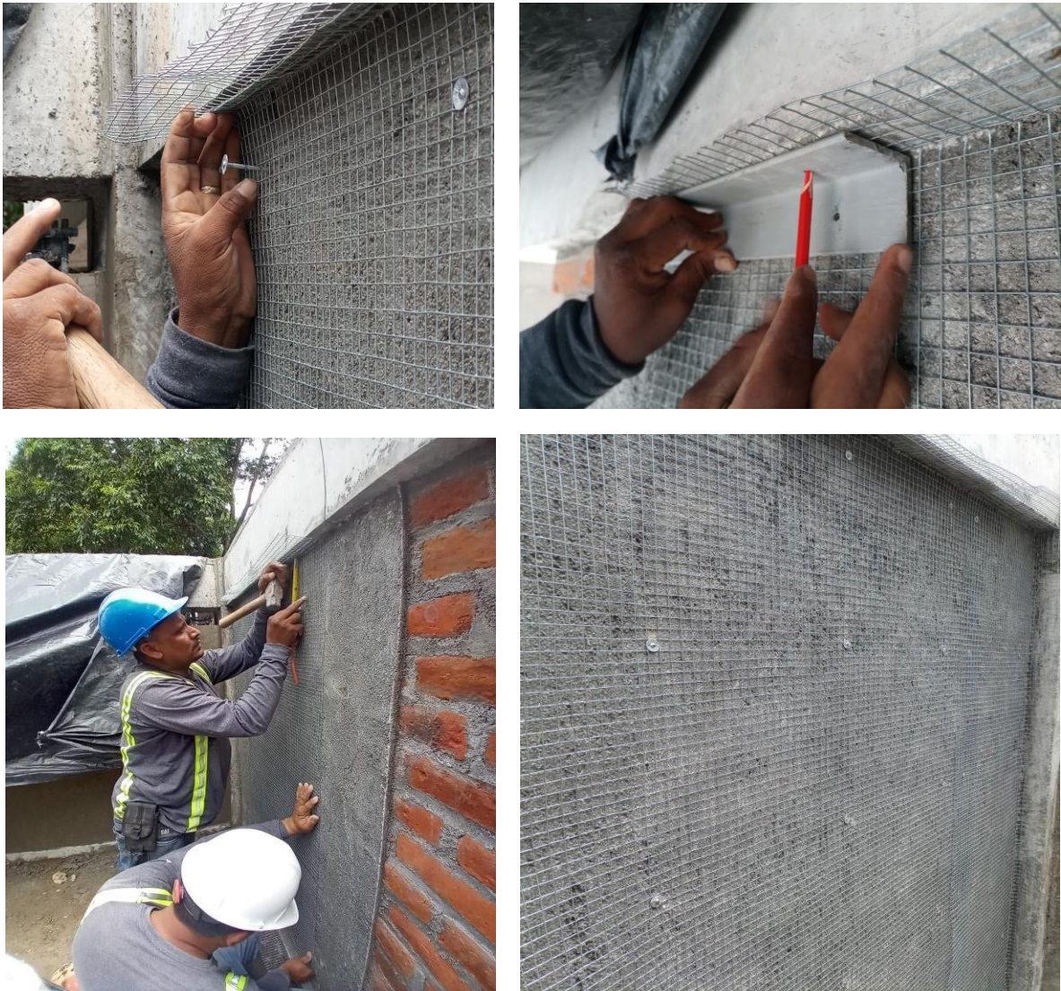
Figura 3.7-3 Laminado de ferrocemento.
