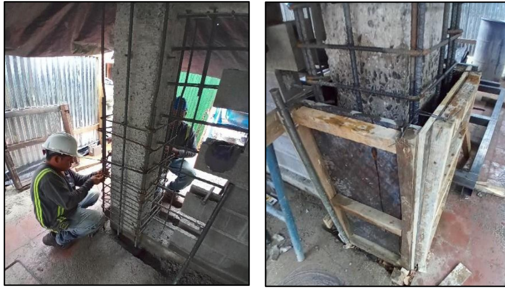
Figura 3.2-4 Proceso constructivo para reforzamiento de columnas.
