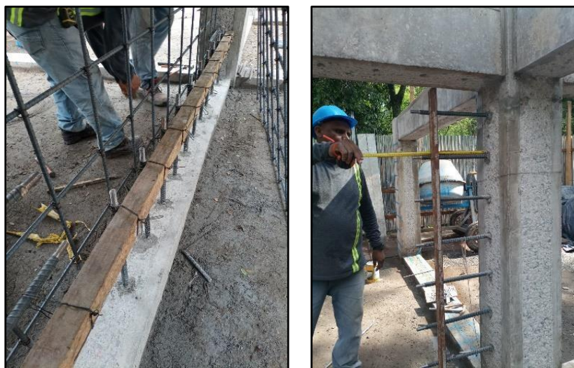
Figura 2.2-6 Instalación de varilla o perno de anclaje
