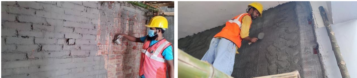
Figura 3.7-5 Trabajos con mortero.
