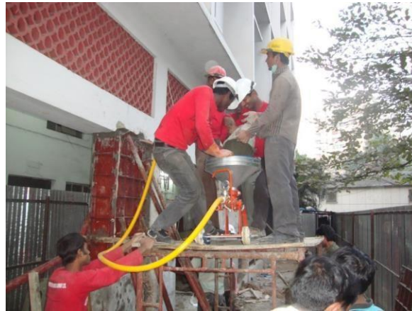
Figura 2.5-1 Colocación de Grout con bomba.
