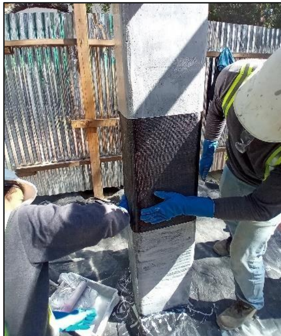
Figura 3.6-3 Fotografía de envoltura de fibra de carbono
