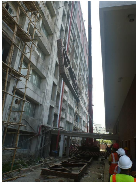
Figura 3.5-3 Izado con grúa del arriostramiento con marco de acero.
