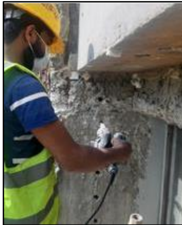
Figura 2.2-4 Limpieza de agujeros por medios mecánicos.
