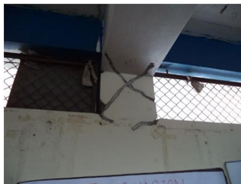
b) Grietas por cortante tras remover repello.
