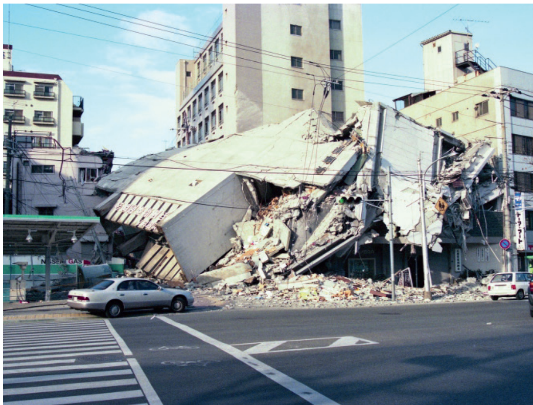
Figura 4: Foto mostrando diferentes niveles de daño dependiendo del código sísmicos aplicado
