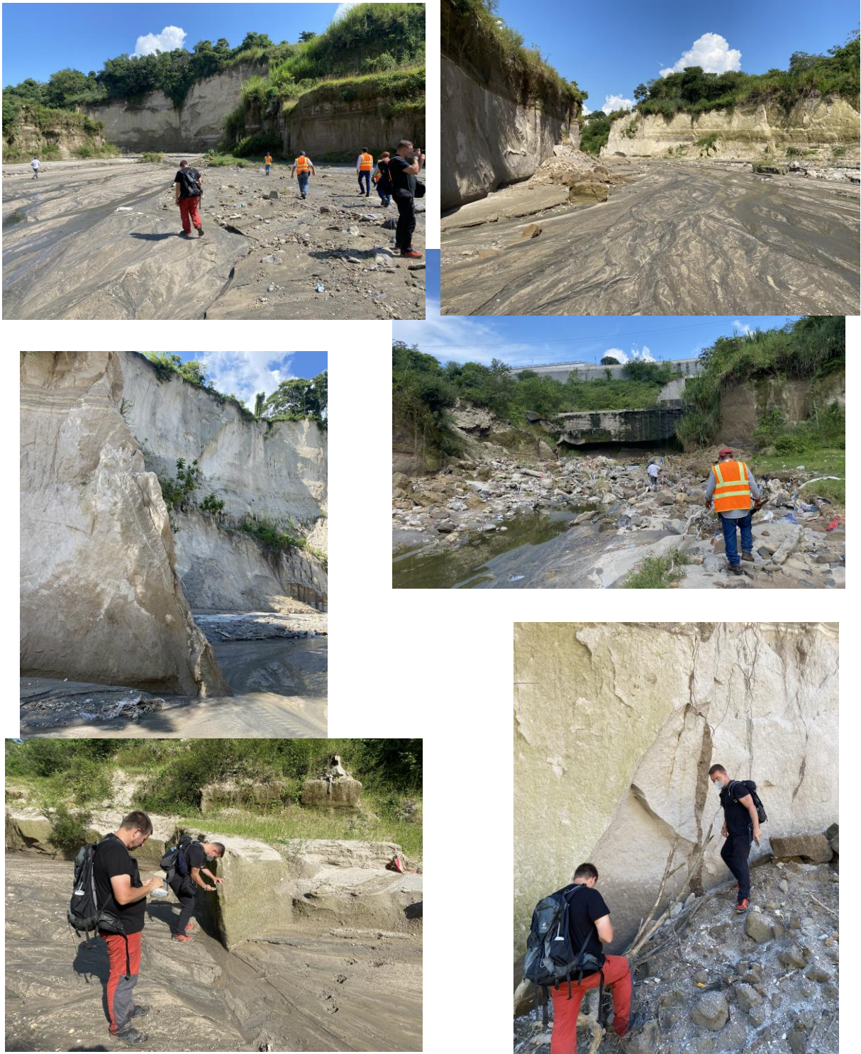
Fig. 4 Situación de Arenal Seco (Ilopango) observándose fallamiento y cambios debido a intervención antrópica en sector
