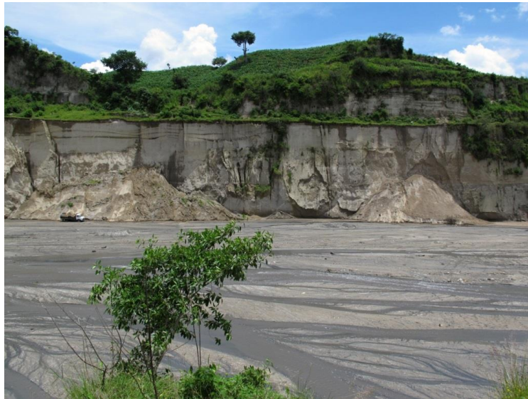
Foto 46 Derrumbes de las paredes del Cañón de Río Las Cañas, provocados por erosión lateral de río.
