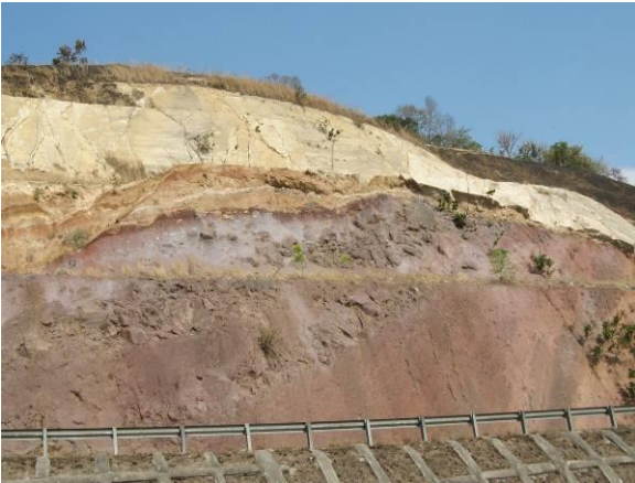
Fig 29c Flujos de lava de dacita/andesita argilizada que se asocian con domos de dacita en la Carretera de Oro; en la cubierta superior hay TB5/TB6, ignimbritas de la caldera Ilopango (+13.7377516, -89.1588142)
