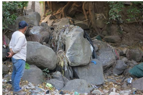
Fig. 53f Depósitos de flujos de escombros recientes, Qda. Las Lajas (+13.7287441, -89.2214138)
