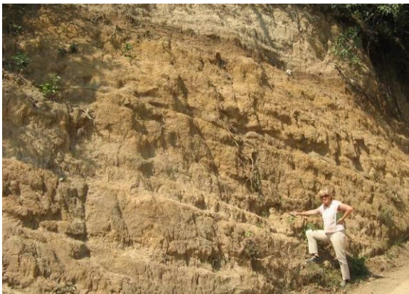
Fig. 33a Sucesión de la caldera de Coatepeque, tobas pomez/tefra, con un horizonte de paleosuelo pronunciado en la parte superior Cordillera Bálsamo al sur de Santa Tecla (+13.6707971, -89.3271514)
