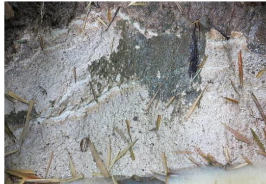
Fig. 33f Toba de pómez argilizada/meteorizada en la base del deslizamiento de Las Colinas; obsérvese las fisuras de corte iniciales (relacionadas a reptación?) (+13.6625077, -89.2856874)
