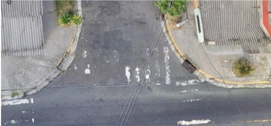
Imagen 23. 15. Dos Tragantes conectados a un mismo pozo con diferente tipología. Fuente: Google Earth.
