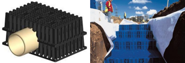
Izquierda: Celda plástica para la acumulación de las aguas lluvias con colector. Fuente: Durman. Derecha: Instalación de celdas en una zanja. Fuente: Amanco
