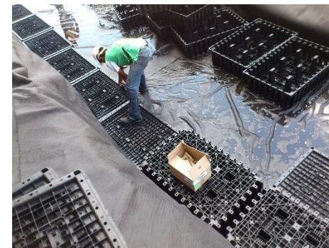
Instalación de celdas plásticas. Fuente: Durman
