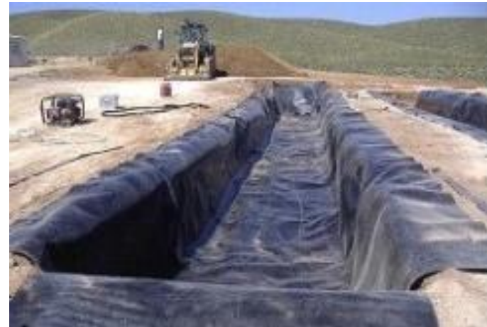
Geotextil no tejido en zanja de infiltración aún por rellenar. Fuente: https://arpimix.com/productos/geotextil-no-tejido-de-polipropileno/attachment/geotextil-no-tejido-polipropileno-06/
