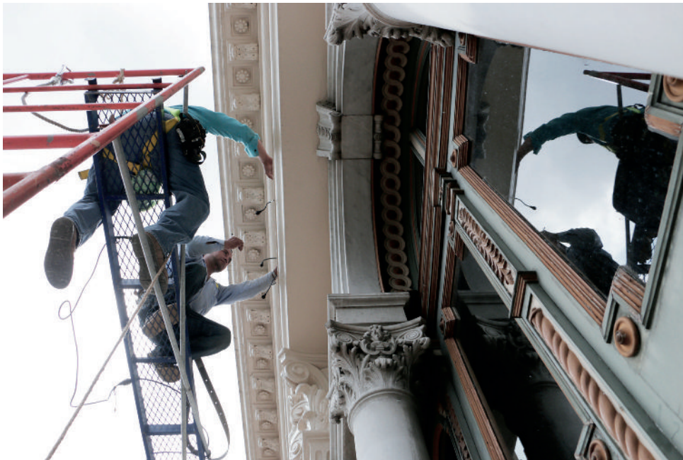
Remozamiento de fachadas en inmuebles emblemáticos, como el Palacio Nacional
