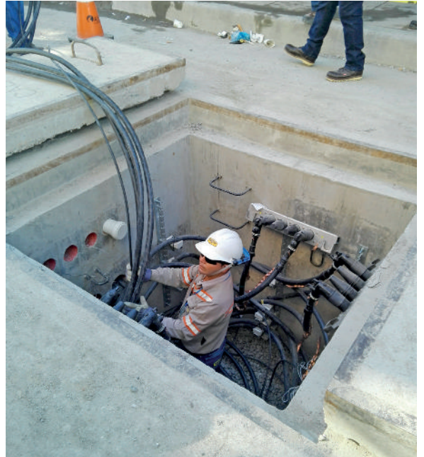
Obras de canalización
