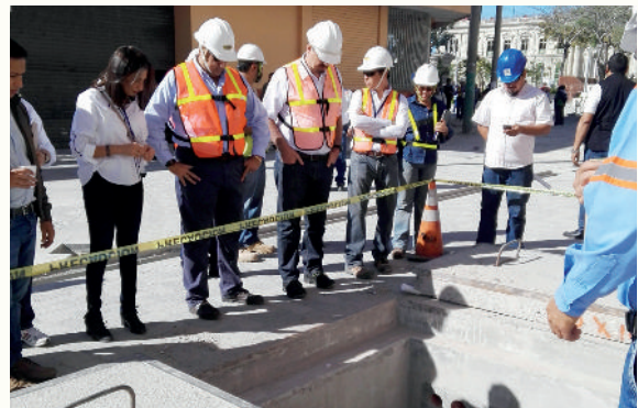
Supervisión de obra OPAMSS y AES
