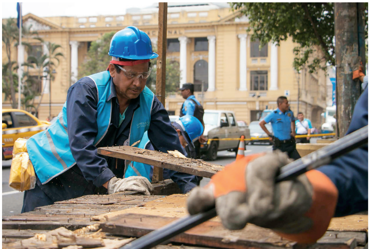
Desmontaje de infraestructura de comercios informales en el Área de Intervención. Fuente: UTE.
