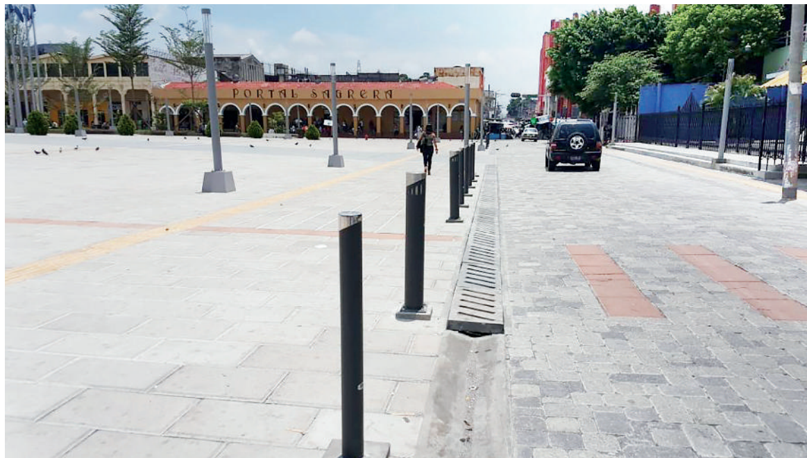
Nuevo Corredor Urbano que unifica la Plaza Libertad con la Iglesia el Rosario. Al fondo, los portales La Dalia y Sagrera
