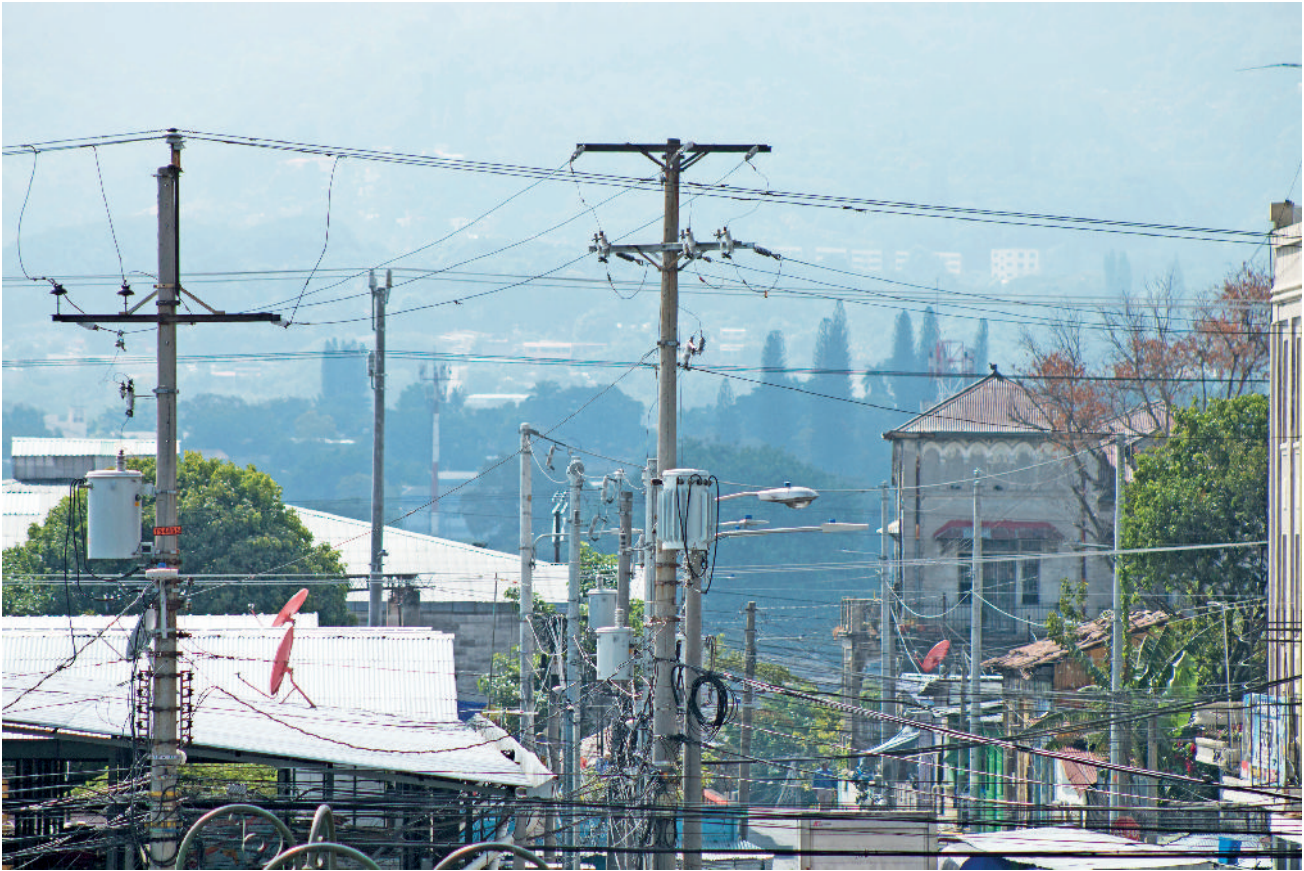
Contaminación visual que representaba el tendido del cableado aéreo en en el Área de Intervención
