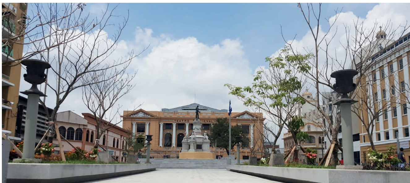
Plaza Morazán. Al fondo, el Teatro Nacional y a un costado, el edificio del antiguo Banco Salvadoreño
