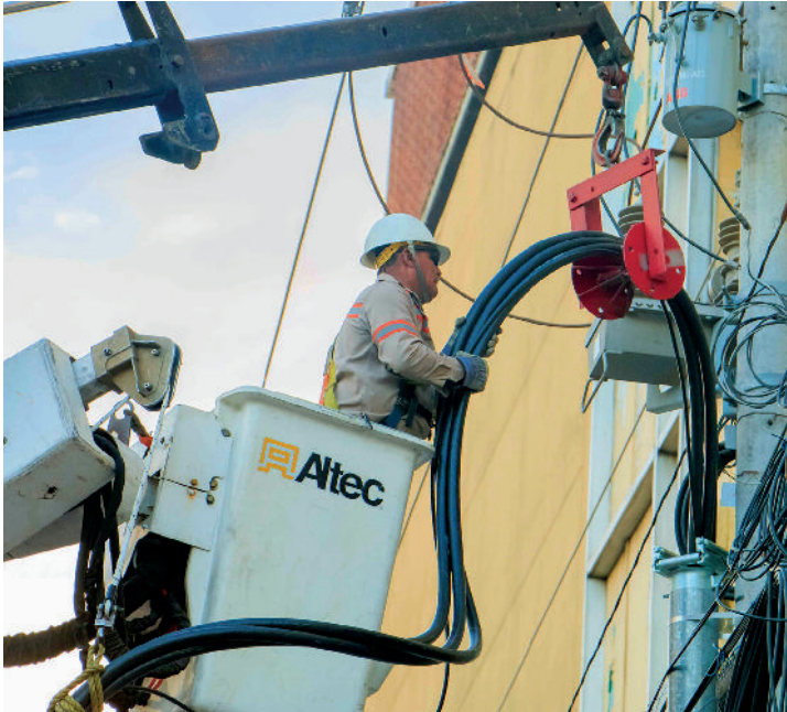
Preparación para el retiro de cableado aéreo
