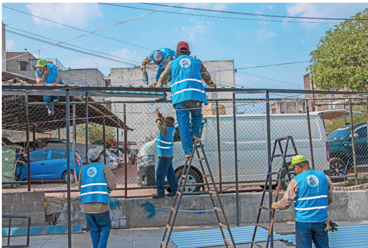
Alternativas provisionales para vendedores reubicados del Área de Intervención
