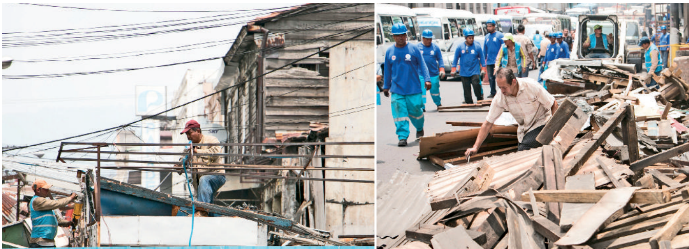
Desmontaje de infraestructura de los comercios informales en Calle Delgado, año 2015
