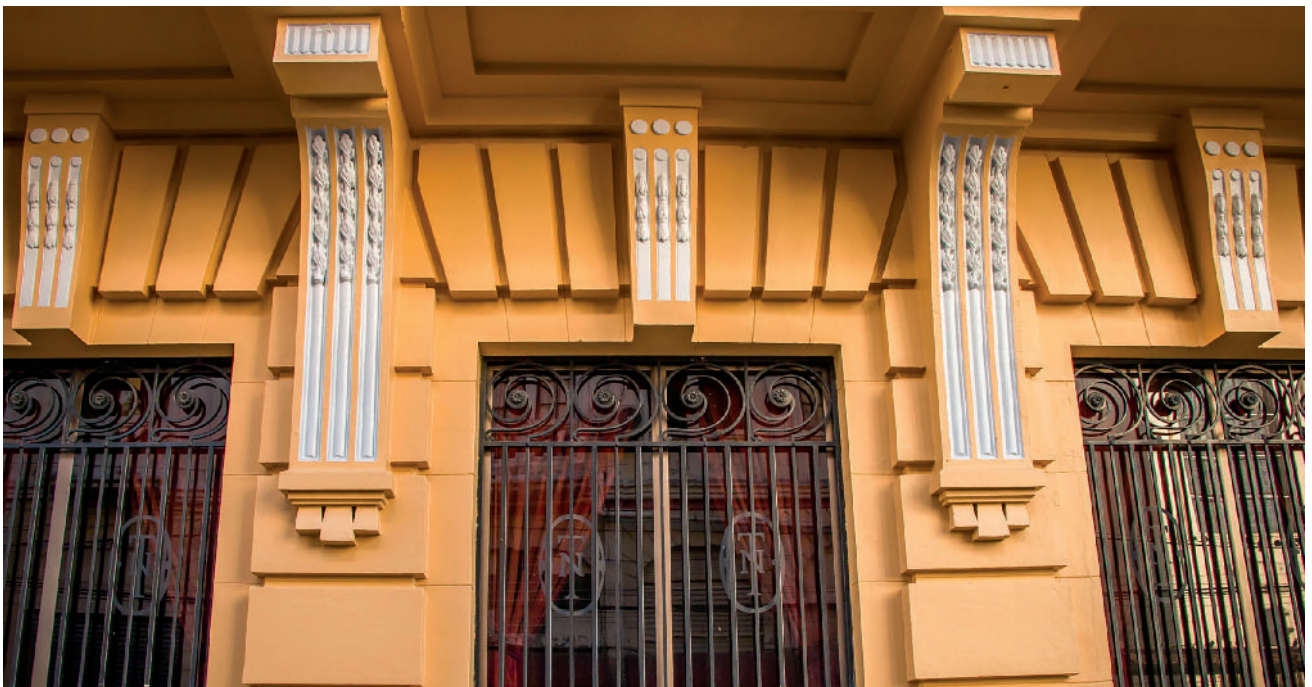
Sección de fachada del Teatro Nacional restaurada
