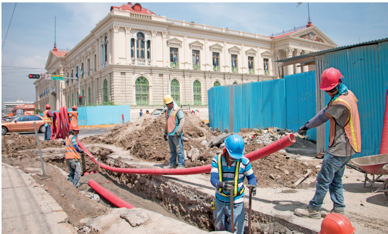
Colocación de ductería subterránea flexible, para la conducción de redes de comunicación
