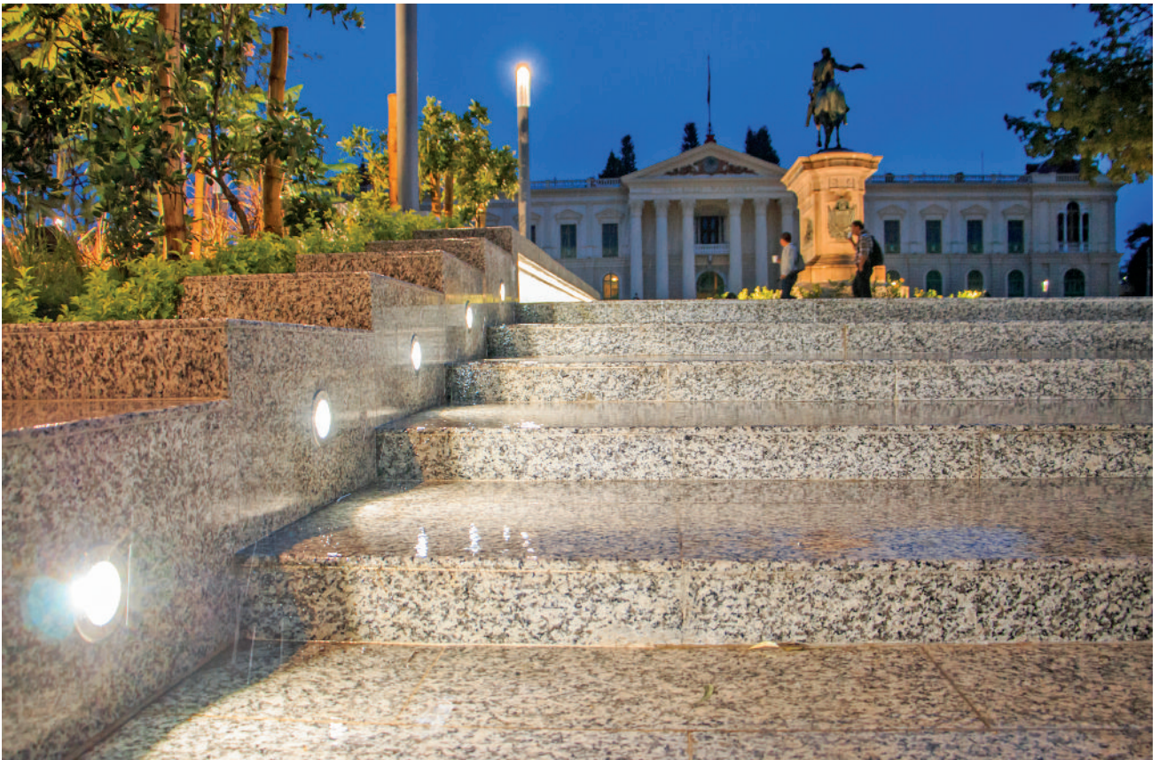
Uno de los nuevos accesos a la Plaza Barrios que conduce al atrio de la Catedral Metropolitana, y muestra de la luminaria incorporada a la obra
