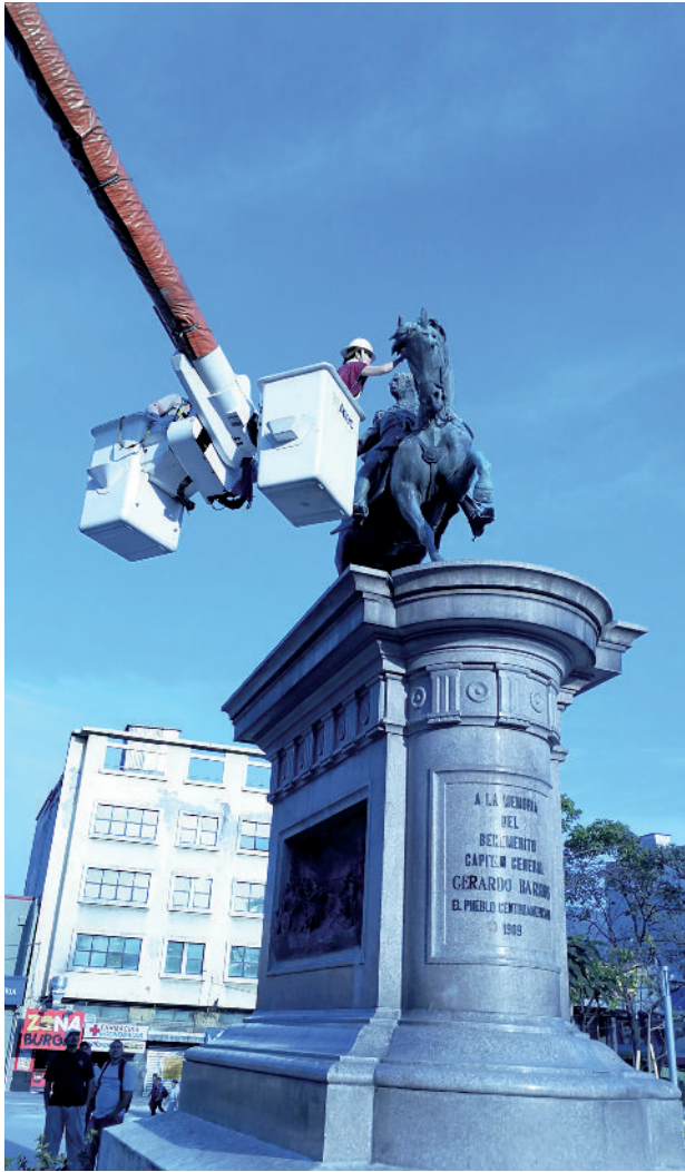
Verificación y evaluación del estado de conservación del monumento de Gerardo Barrios
