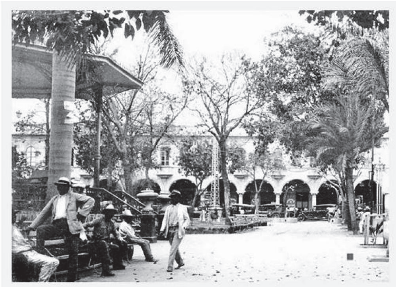
Calles pavimentadas. Fuente: UTE.
