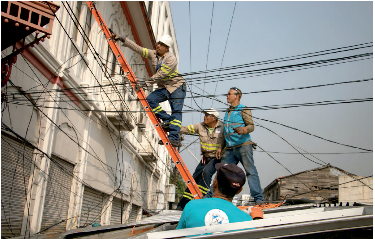
Desmontaje del cableado aéreo para luego seguir con las obras de cableado subterráneo
