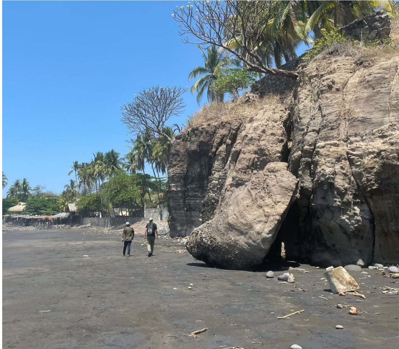
Derrumbe Playa de Martín/Km 59
