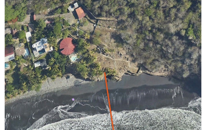
Zona de fallas en Playa de Martin / Km 59
